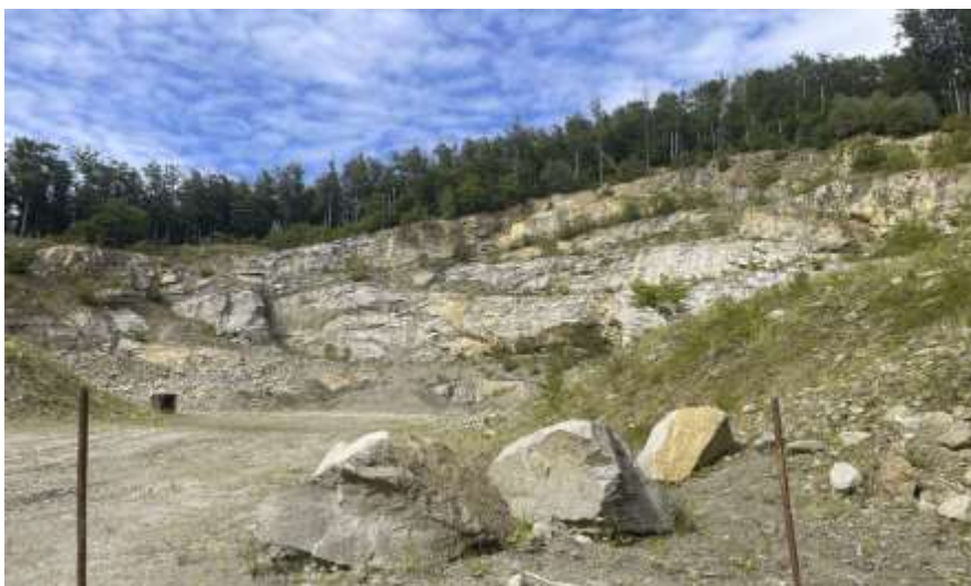
Obr. 44: Celkový pohled umístění a těžby nevýhradního ložiska Bystřička a do prostoru jeho plánovaného rozšíření
