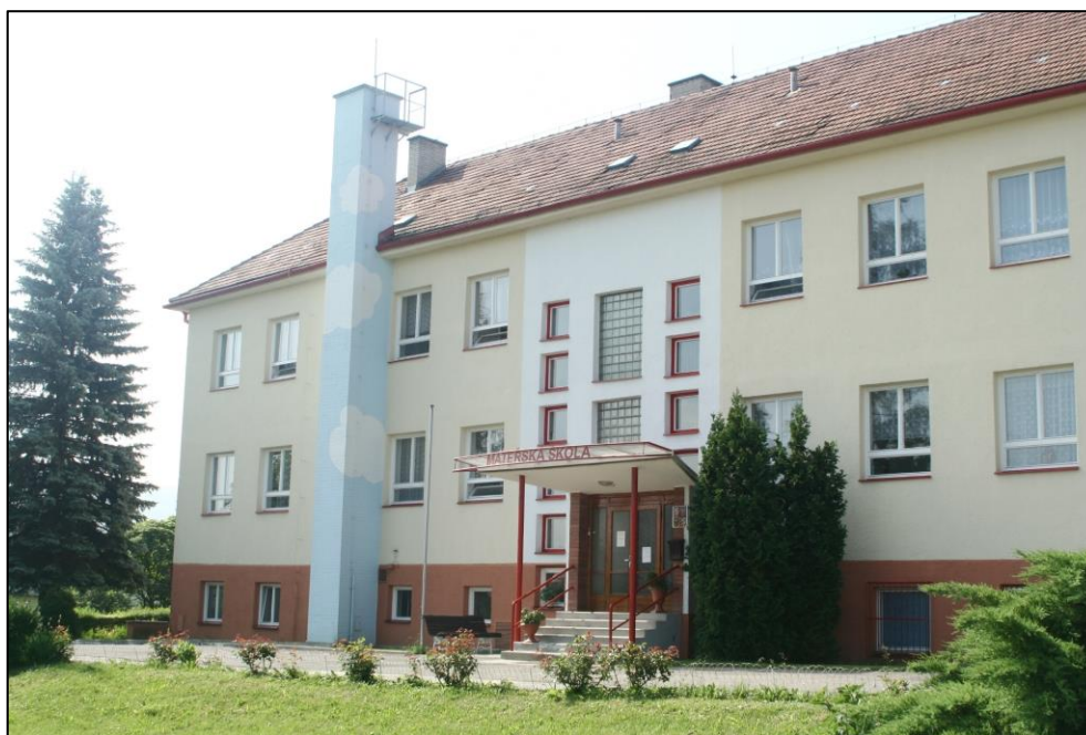
Obr. 13: Budova MŠ Vizovice
