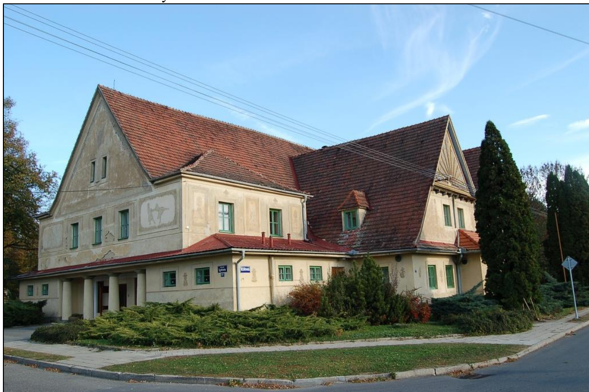
Obr. 7: Budova Sokolovny ve Vizovicích
