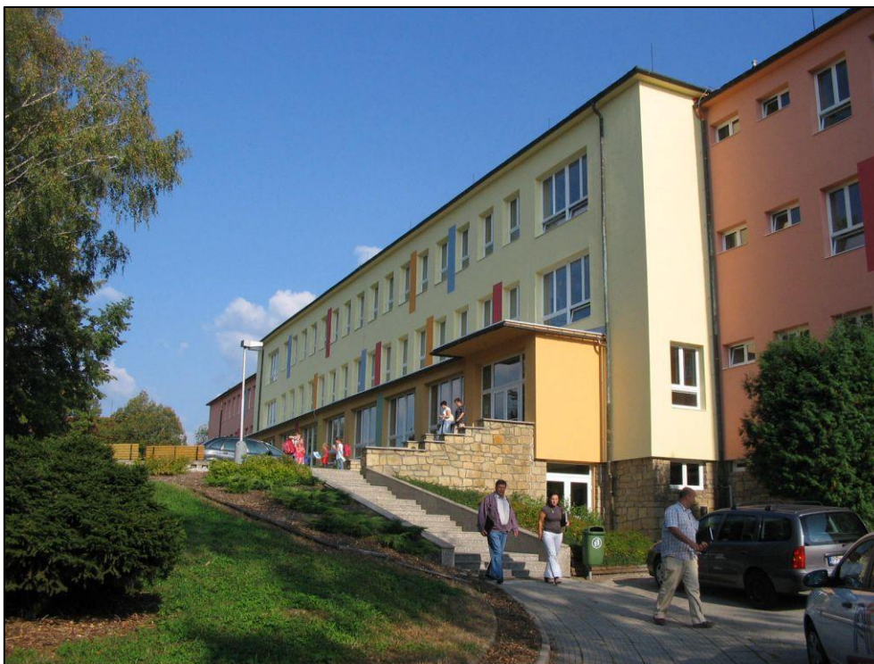
Obr. 14: Budova ZŠ Vizovice na ulici Školní
