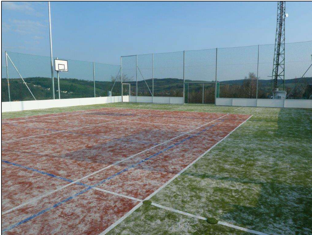
Obr. 19: Víceúčelové hřiště ve Vizovicích
