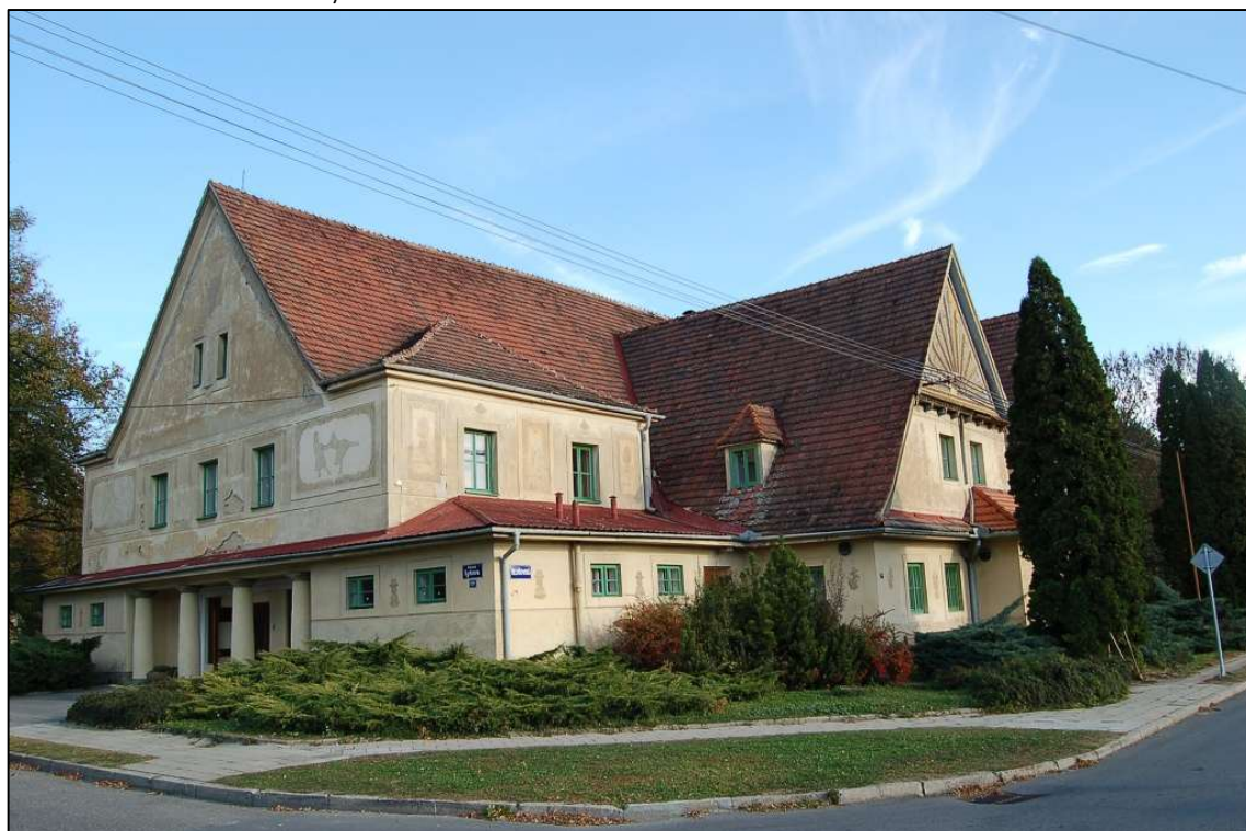
Obr. 7: Budova Sokolovny ve Vizovicích
