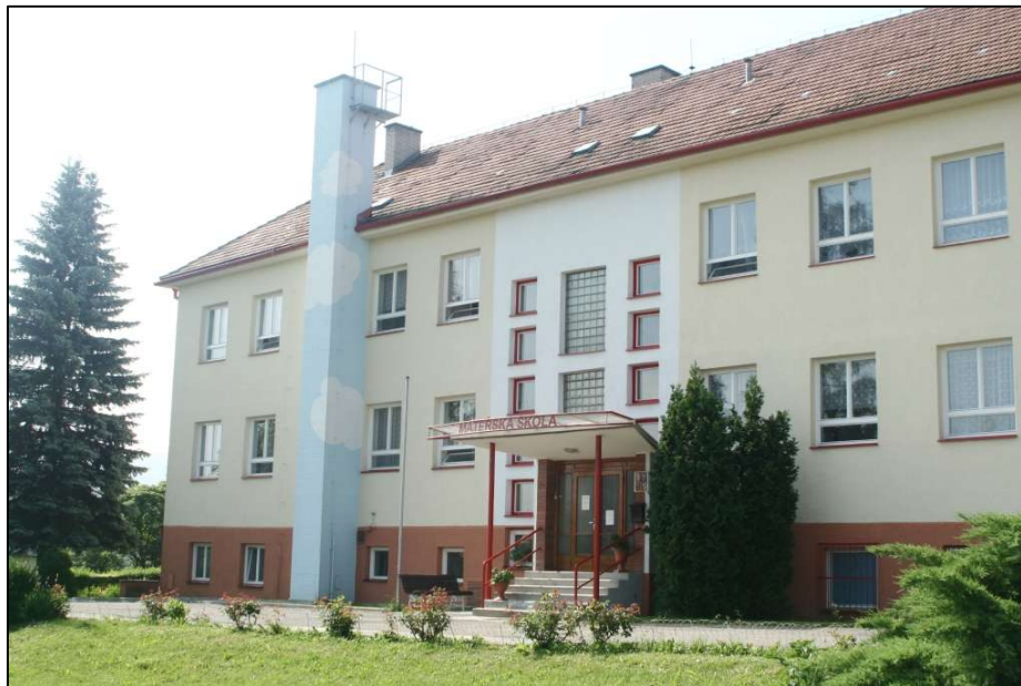
Obr. 13: Budova MŠ Vizovice
