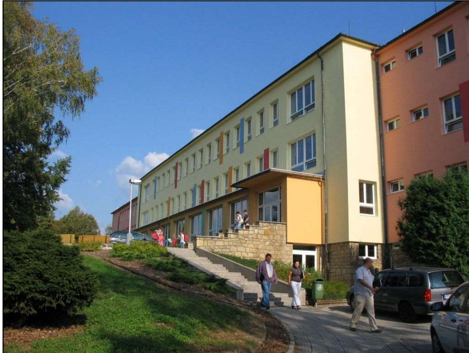
Obr. 14: Budova ZŠ Vizovice na ulici Školní
