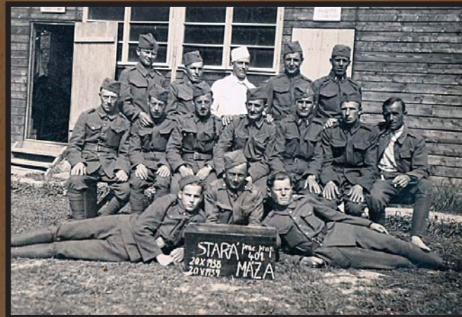
Stavby se účastnil i 401. prapor.
