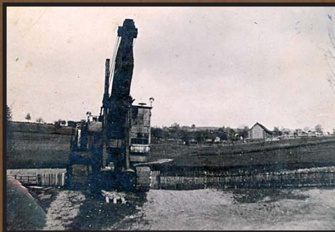
Těžká technika při stavbě dráhy.
