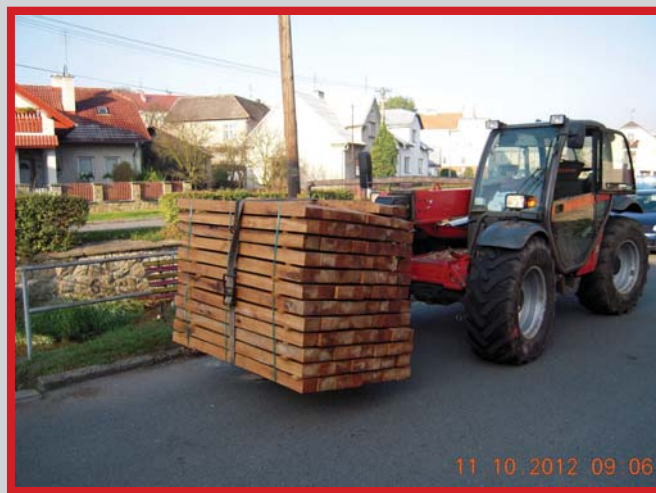
Trámy určené na rekonstrukci mostu.
