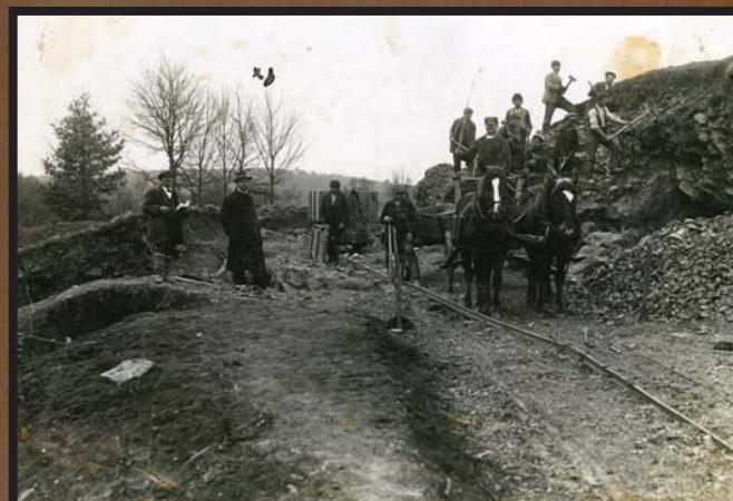
Stavba cesty Chrástěšov - Dešná - 1930.
