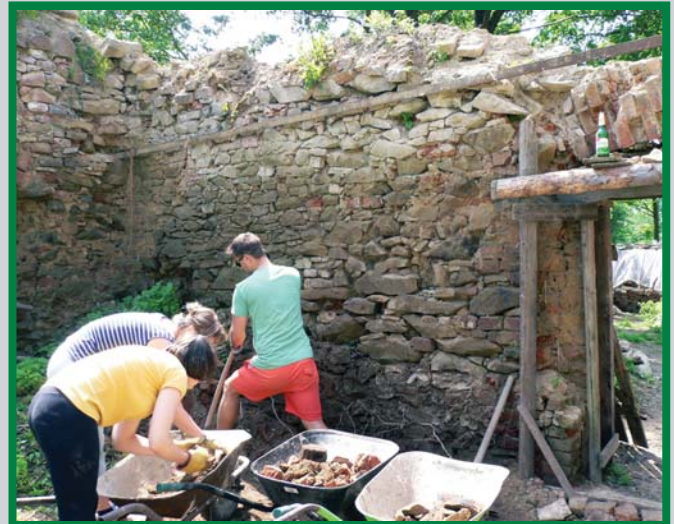
Vyklízení suti z objektu.
