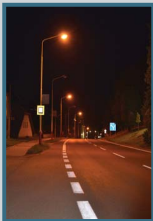
Stávající sodíkové osvětlení - 250 W.
