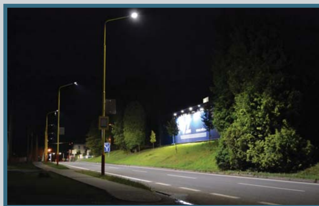
Zkušební LED osvětlení - 80 W, ulice Zlínská, Vizovice.
