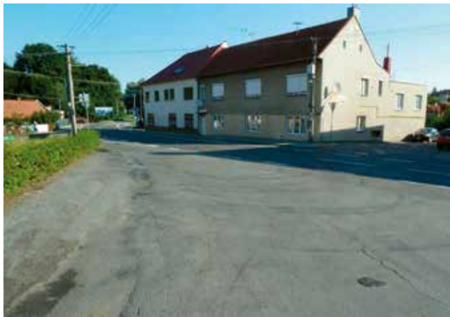
Pohled z ulice Partyzánské
