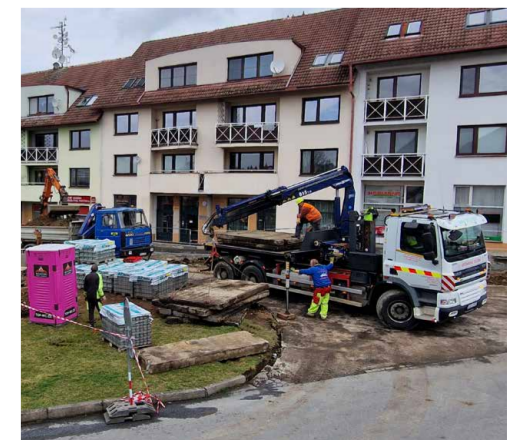
Na stavbě parkoviště před „Rohlíkem“ panuje čilý stavební ruch.
