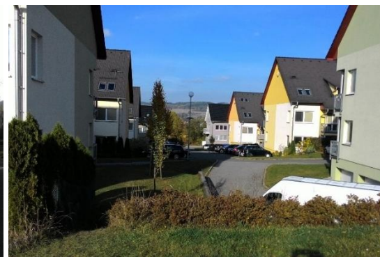
č. 2 vstup z obytného souboru
