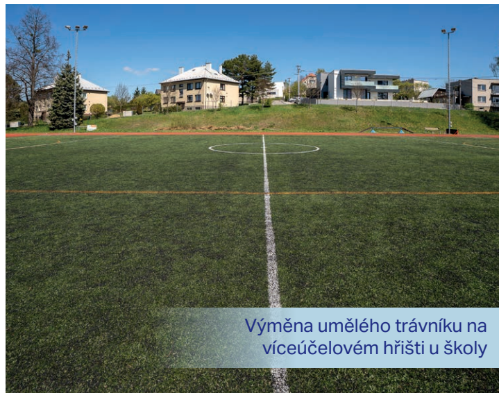
Rekonstrukce víceúčelového hřiště u školy
